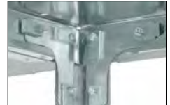
Aussteifung mit Eckplatten
